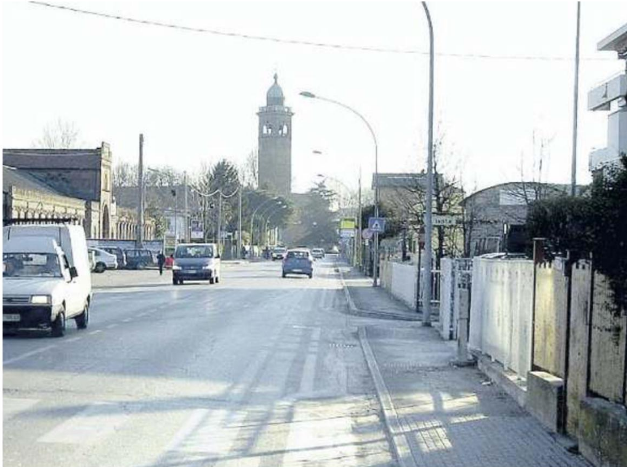
LA STRADA Il tratto viale Orobani nel quale accadde l'investimento, per la precisione al passaggio pedonale vicino a via Gallimberti
