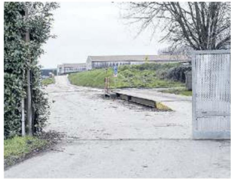
L'IMPIANTO L'ingresso dell'ex Biofer-Amit a Boara Polesine
